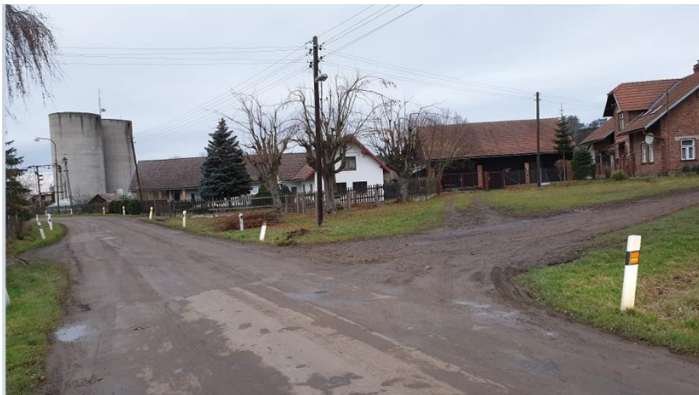
Místní komunikace Semínova Lhota, dne 9. 12. 2020.
